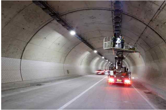
터널 내부 고소점검차 조사
