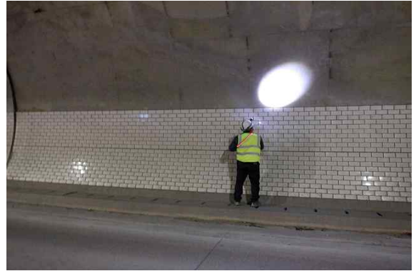
터널 내부 도보조사
