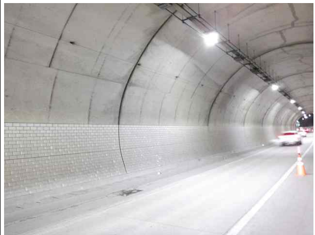
벽체 및 어깨부 전경
